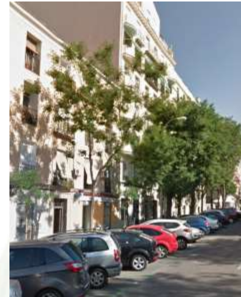
Calle del General Lacy Mala adecuación Porte/Distancia a fachada
